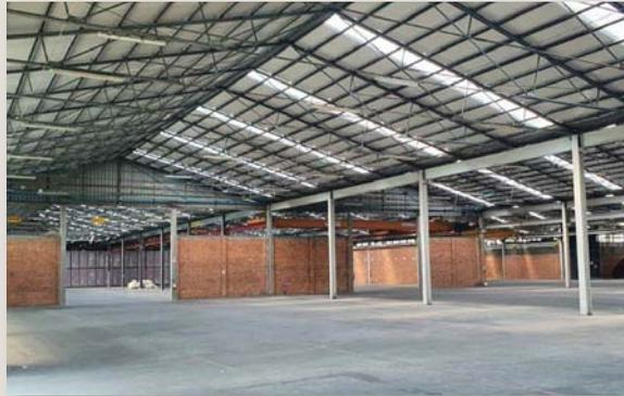
In particolare è stata rinnovata una porzione di copertura di 6.000 mq applicando dei pannelli sandwich termoisolanti ed è stato reso l'edificio completamente eternit free.
